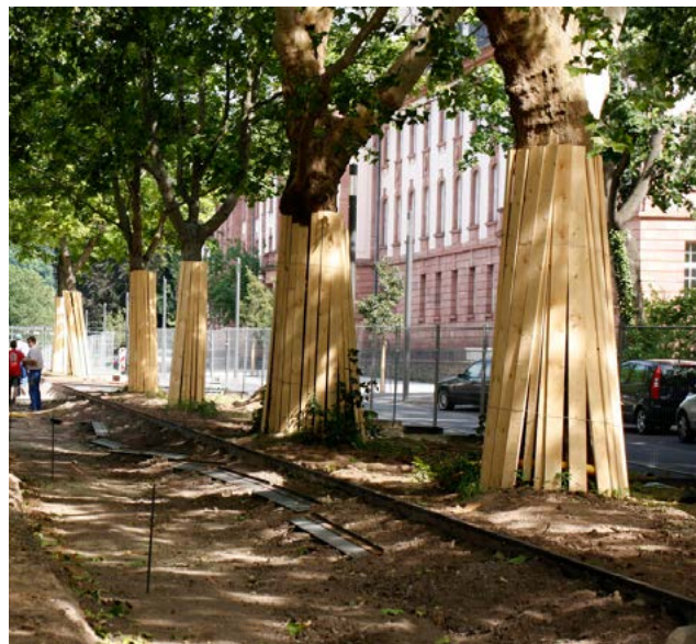
Eksempel hvor det utføres arbeid nær trærne, som er beskyttet med stammevern.
