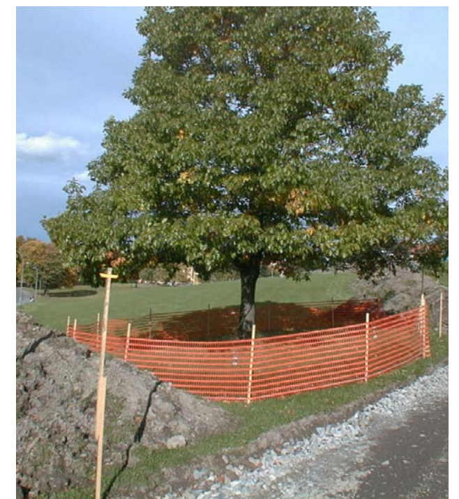
Stammebeskyttelse i form av et enkelt nettinggjerd.
